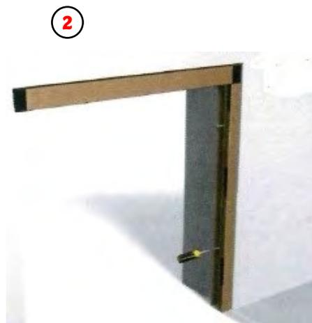
Insérez les platines de fixation par le haut du profil (côté caisson) avant de le positionner contre le mur. Vérifiez que votre profil est bien droit avant de le fixer.
