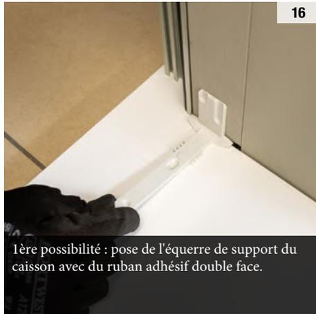
1ère possibilité : pose de l'équerre de support du caisson avec du ruban adhésif double face.
