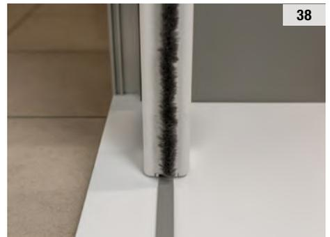
Dégraisser et sécher la surface de fixation avant de coller le ruban adhésif double face.
